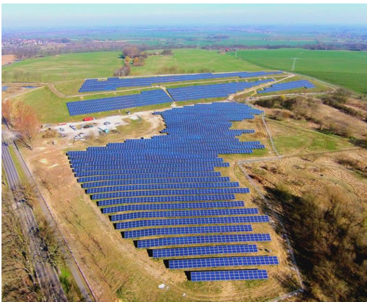
Abbildung 4-3: Luftbild der Altdeponie Seelow
