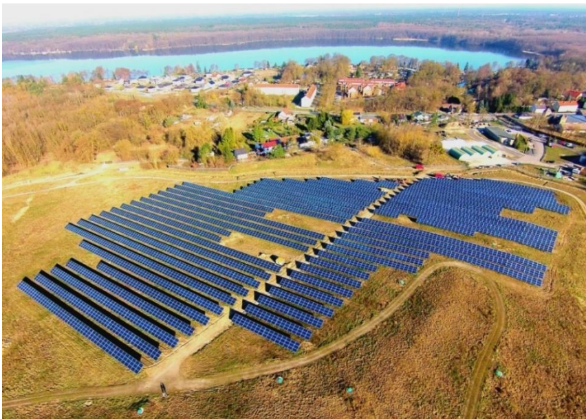
Abbildung 4-2: Luftbild der Altdeponie Hennickendorf
